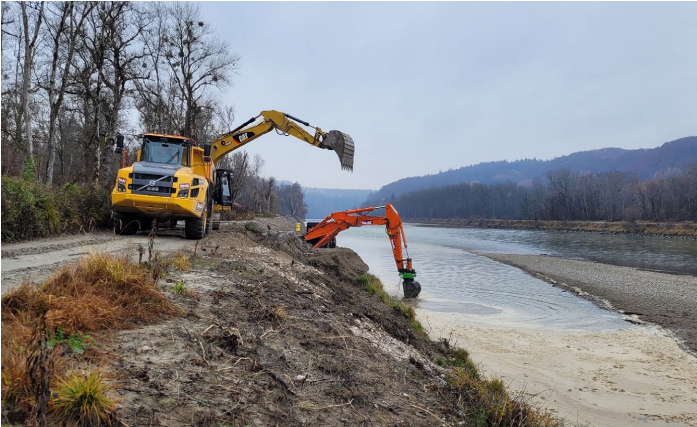
Uferrückbau bei Tittmoning. Das Bild zeigt die Salzach stromabwärts. Links, auf der bayerischen Seite des Flusses, werden die Uferbausteine entfernt. Dank dieser Arbeiten kann die Salzach auf einer Länge von drei Kilometern wieder frei fließen, Foto: WWA
