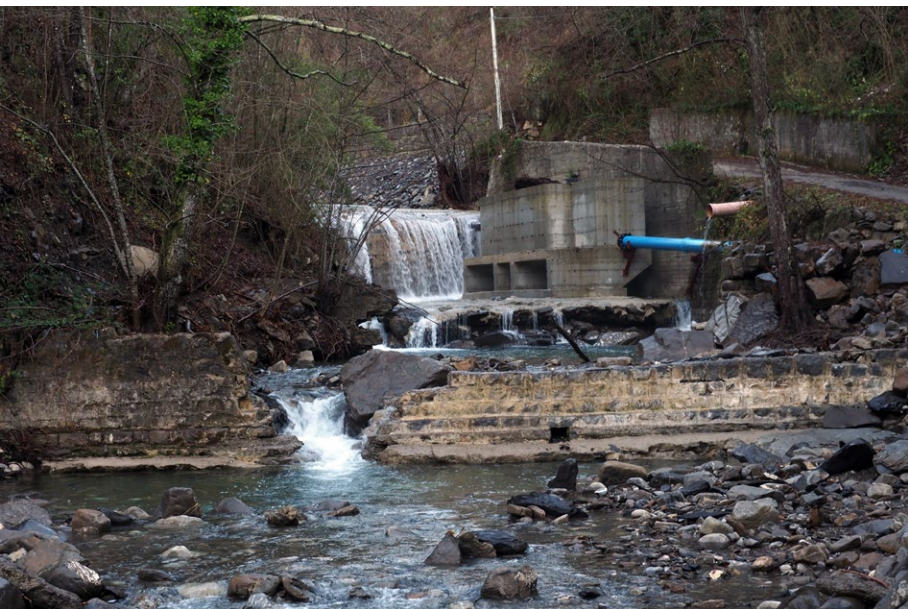
Querverbauungen im Rio Gordale, einem Zuflusses der Nerva. Die Nerva ist ein kleiner Fluss in der italienischen Region Ligurien.
