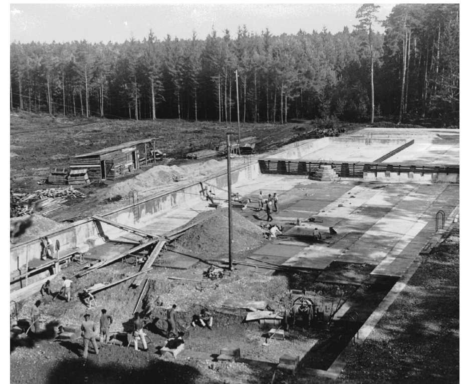
Mit einfachsten Mitteln und Werkzeugen entstand das 50 x 25 m große Schwimmbecken im Freibad. Über dünne, wackelige Latten führen die Arbeiter den Aushub nach oben
